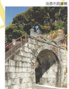
法恩寺踏線橋
