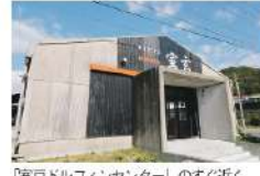
「室戸ドルフィンセンター」のすぐ近く
