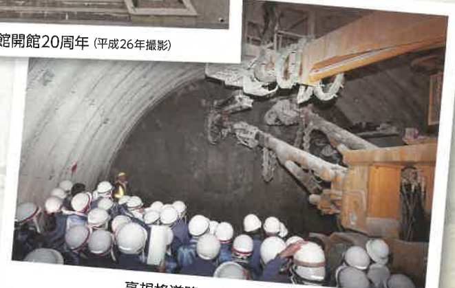
高規格道路工事 (平成10年撮影)
